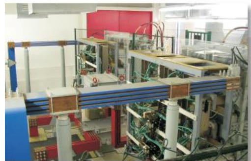
Pohled na soustrojí dvou usměrňovačů s „nulovou“ tlumivkou
