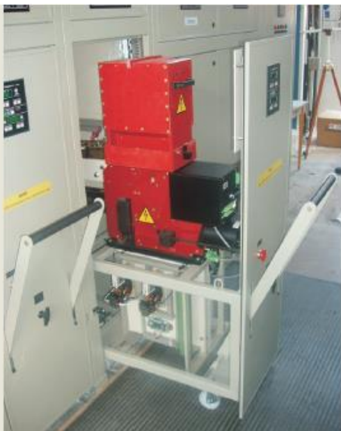
Выдвинутый возик шкафа фидера с быстродействующим выключателем
