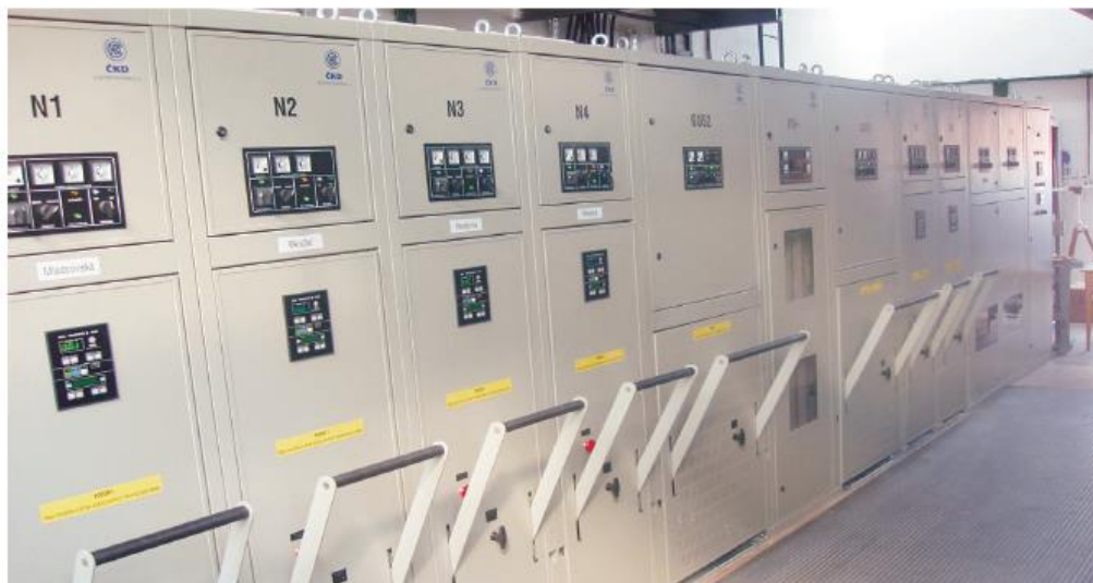
Распределители постоянного тока на станции Йижни Свахи, ЧР
