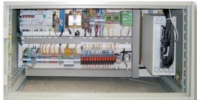
Вспомогательные контуры преобразователя с микропроцессорным регулятором EMADYN
