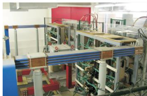
Вид на агрегат двух выпрямителей с „нулевым“ дросселем
